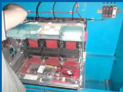
Ingeniero de Direct Response instalando ACB de Retrofit
