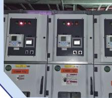
**Solución:** Mejoramiento de los sistemas de protección y medición de switchgear ABB modelo UNIGEAR 17.5 kV.
