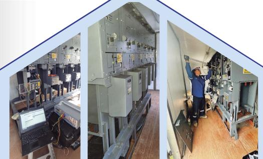
**Solución:** Mantenimiento correctivo y preventivo de switchgear de media tensión 15 kV, Schneider Electric, modelo Ringmaster.
